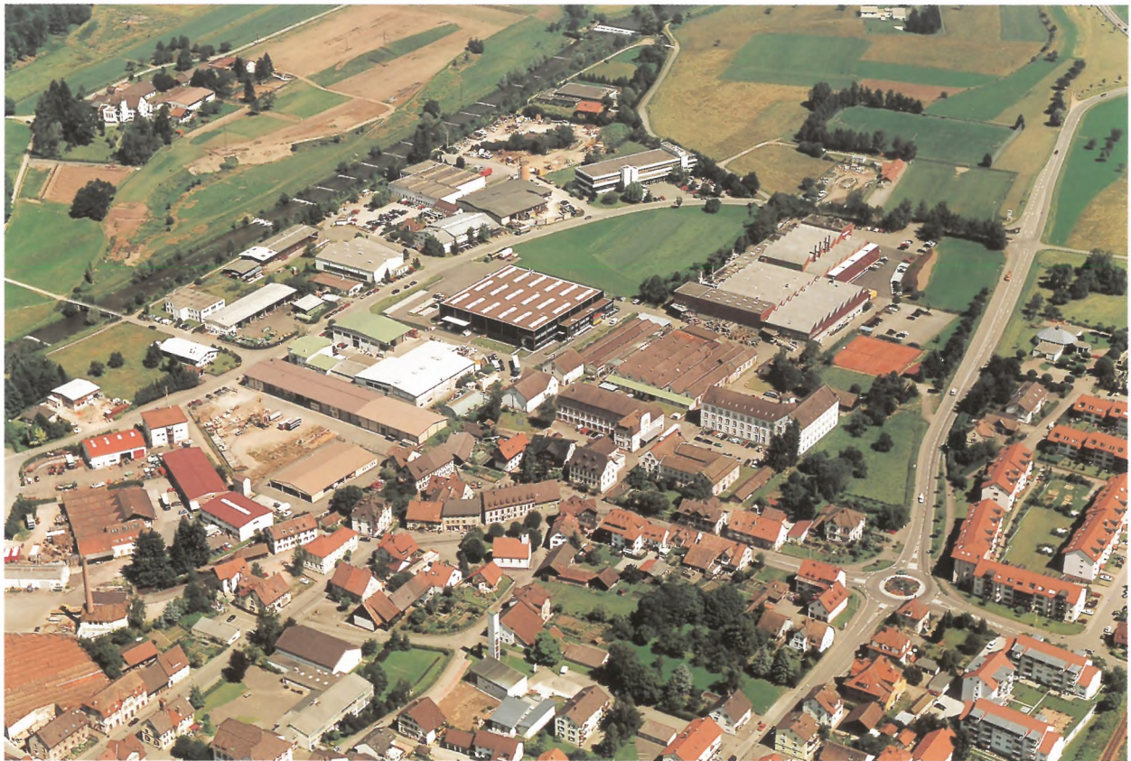
Der Hochbau und die anschließenden Sheddächer im Areal Krafft-Rietschle
